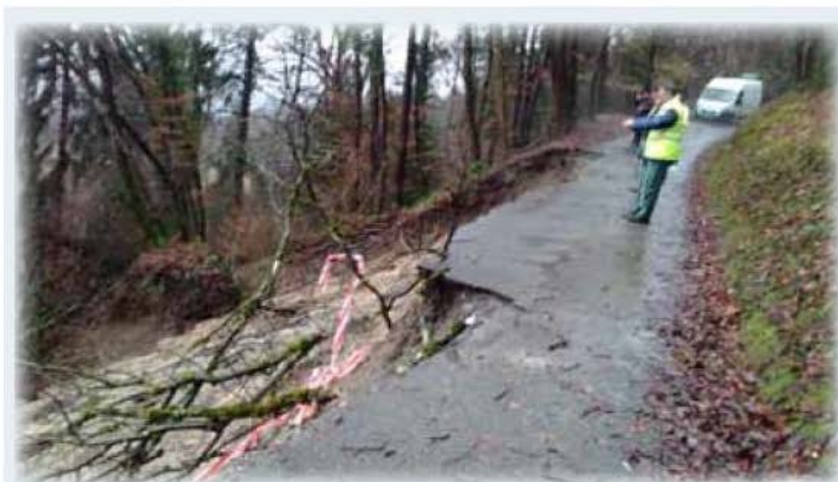
Effondrement de la chaussée et du talus (janvier 2018)
